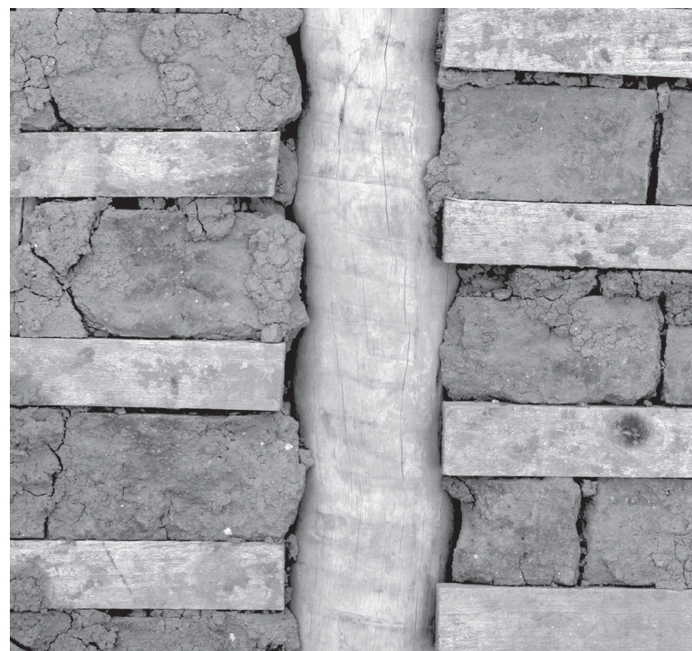
Fig. 41. e 42. Opy e detalhe de construção.
