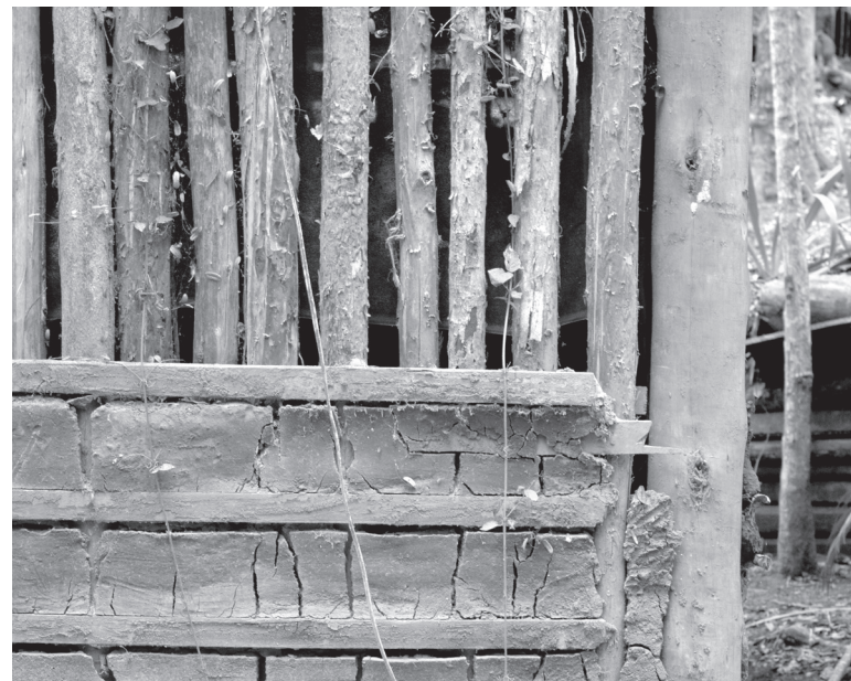
Fig. 37. e 38. Detalhes de construção em madeira e terra.
